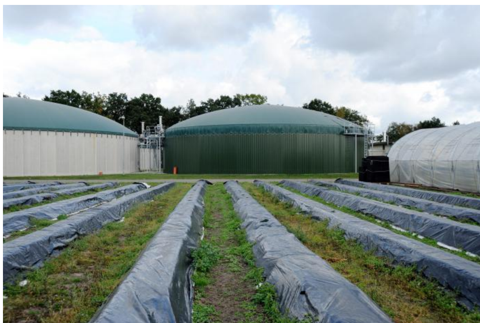
Рис. 2 – Куполообразные реакторы с газгольдером мембранного типа
