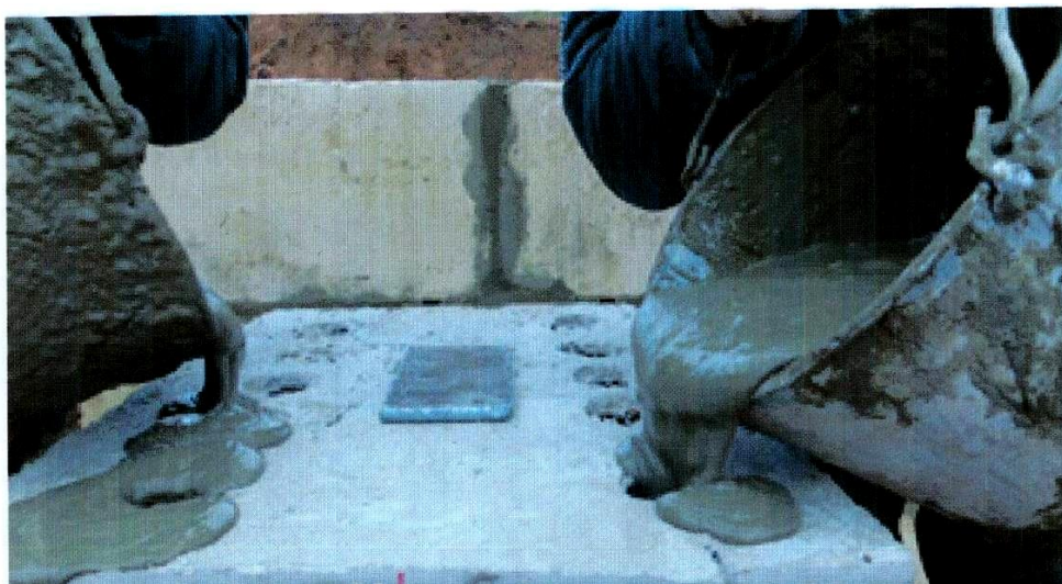
Рис. 4 – Заполнение отверстий клеем для последующего соединения с колонной
