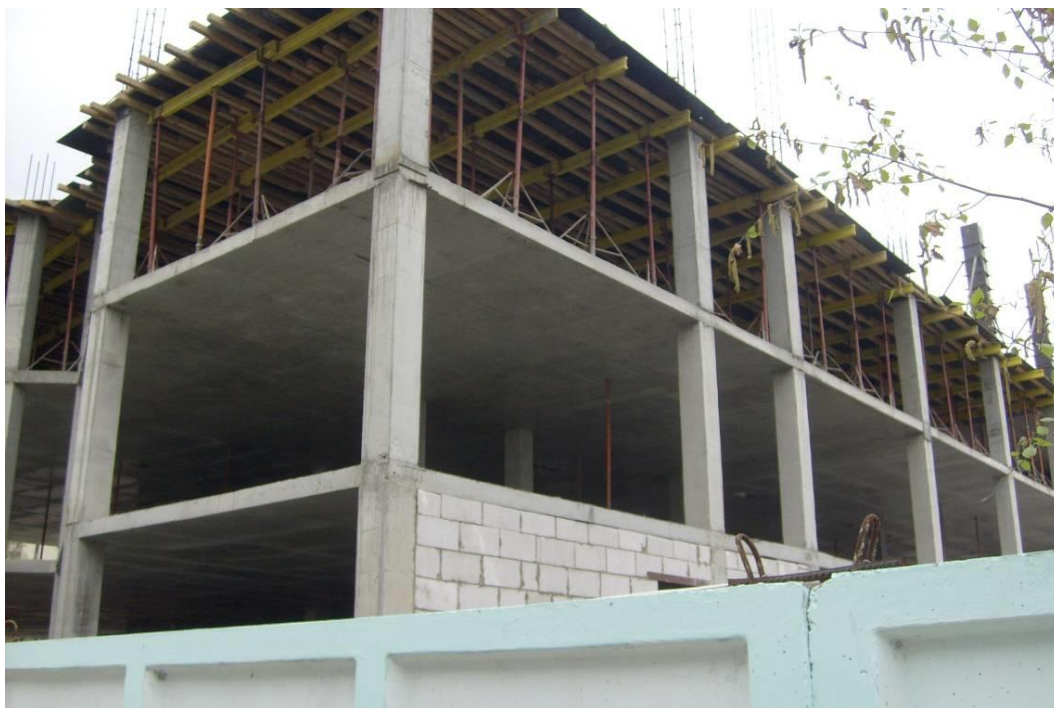
Рис. 1 – Монолитно-каркасное здание с безригельным и безкапитальным перекрытием
