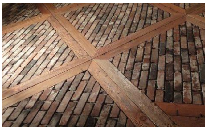
Рис. 3 – Пример исполнения пола из старого кирпича
