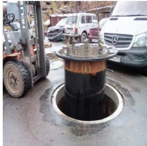
Рис. 1 – Фильтрующие патроны для систем ливневой канализации: а – схема конструкции; б – процесс замена фильтрующего элемента
