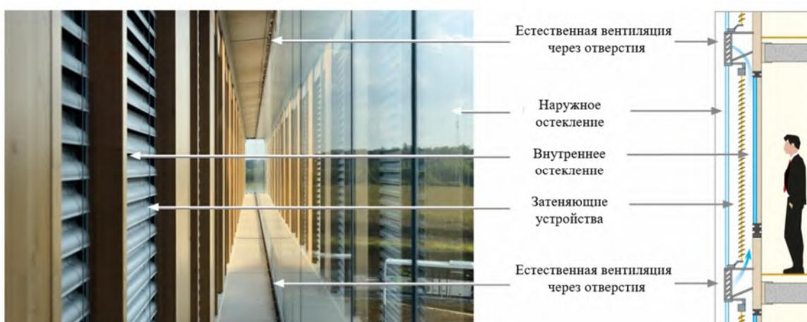
Рис. 1. Конструкция двойного фасада, DSF
