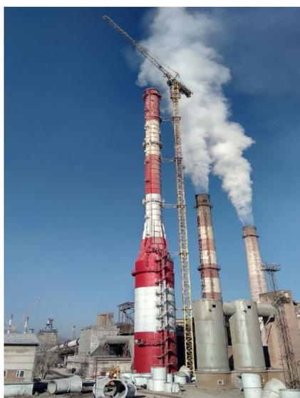
Рис. 2. Стальная самонесущая дымовая труба высотой 160 м после реконструкции
