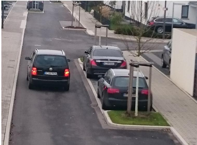
Рис. 3. Пример организации одностороннего движения автомобилей на дороге с прямоугольными направляющими островками
