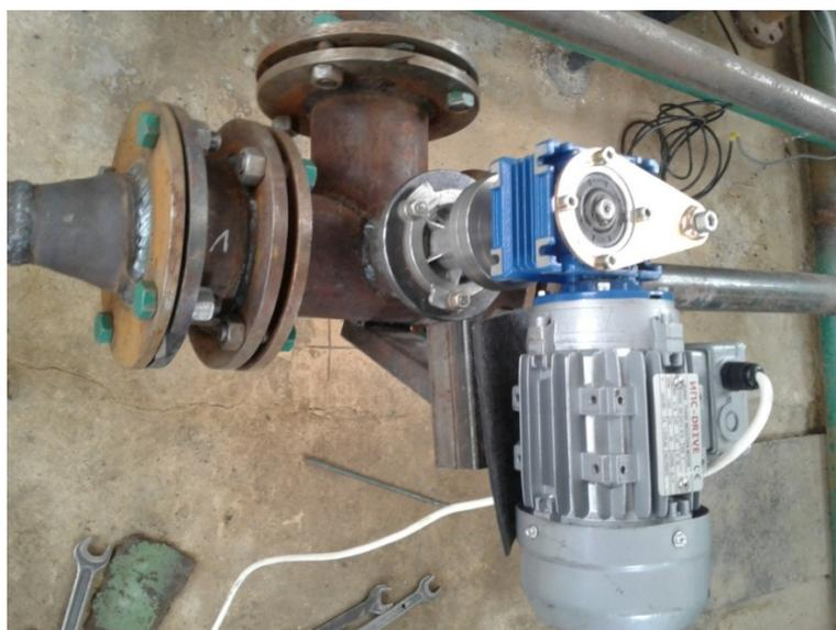
Рис. 3. Внешний вид генератора гидравлического удара
