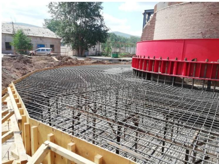
Рис. 1. Фрагмент существующей трубы и закрепление болтами новой трубы в период устройства ростверка
