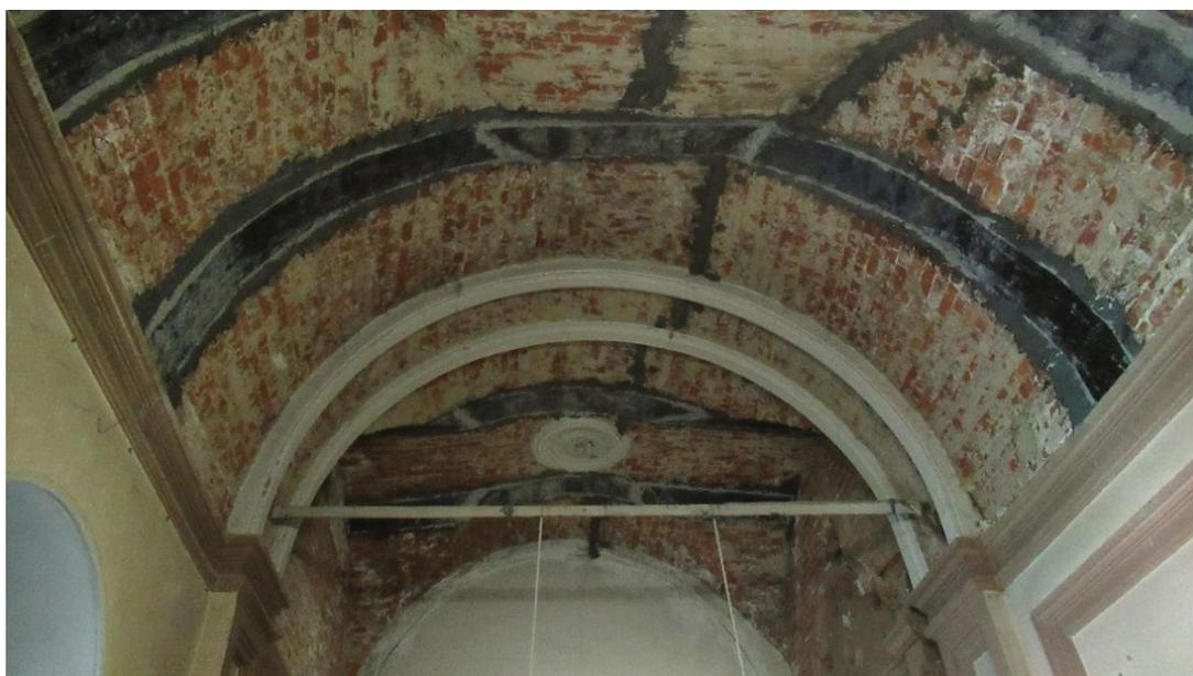
Рис. 2. Усиление конструкций арочного перекрытия Петропавловского собора г. Казани композитными материалами
