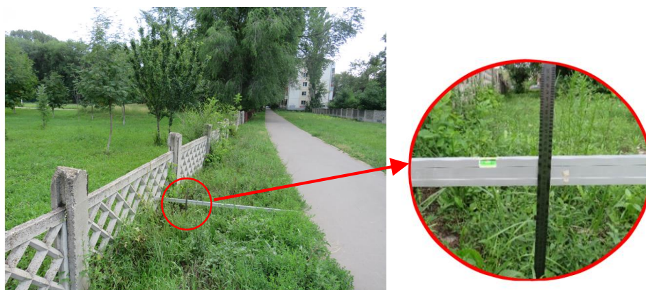
Рис. 3. Общий вид одной из точек промера высотных отметок (замер уровня грунта относительно ограждения)
