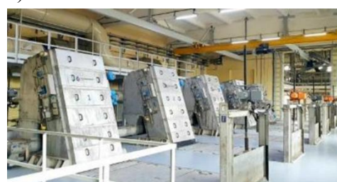
Рис. 3. Реконструкция сороудерживающего комплекса:
