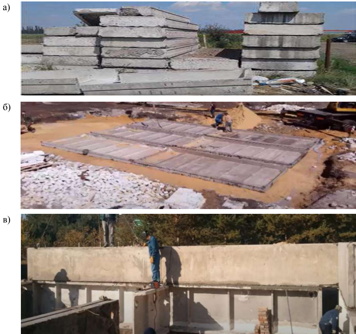
Рис. 4. Общий вид стенчатых и плитно-ребристых фундаментов, изготовленных из вторичных строительных материалов: а – отходы ребристых плит перекрытия при поэлементном демонтаже зданий и сооружений; б – сплошной плитный фундамент из ребристых плит перекрытия; в – стенчатый фундамент из ребристых плит перекрытия
