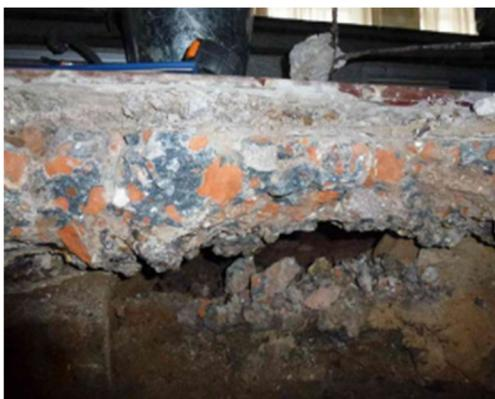
Рис. 2. Вид просадки грунтового основания полов на исследуемом объекте
