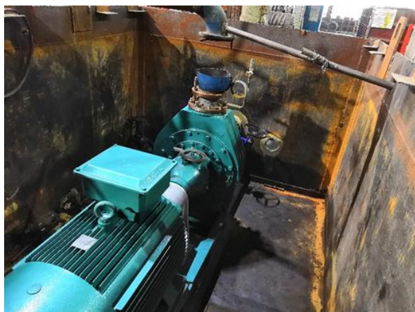
Рис. 3. Расположение электронасосного агрегата АХН 400/80.2 внутри понтона
