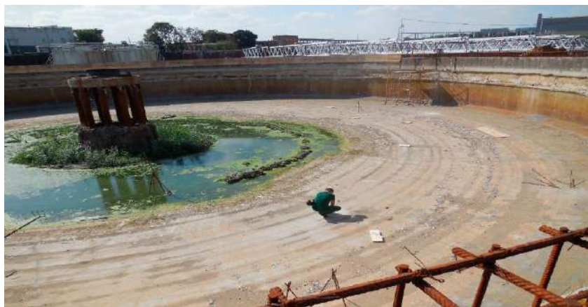
Рис. 1. Внешний вид исследуемого первичного отстойника на канализационных очистных сооружениях, г. Москва
