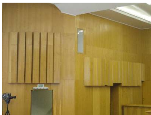
Рис. 2. Внешний вид воздухораспределительных устройств, интегрированных в строительные конструкции помещения
