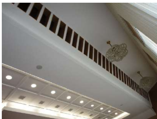
Рис. 2. Внешний вид воздухораспределительных устройств, интегрированных в строительные конструкции помещения
